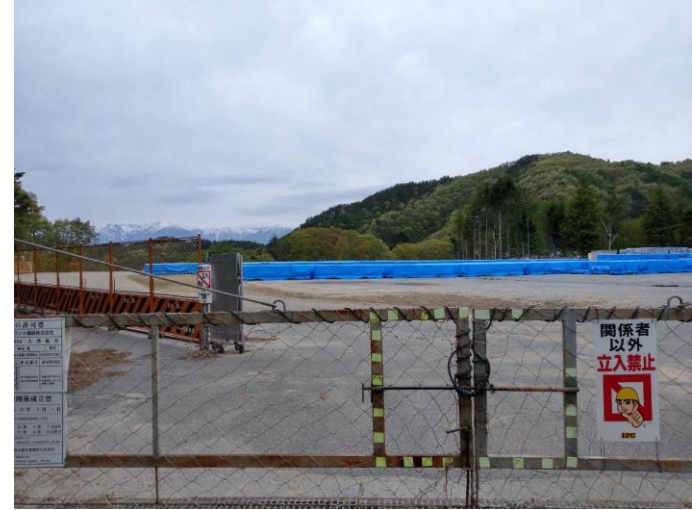
運び込まれたパネル
