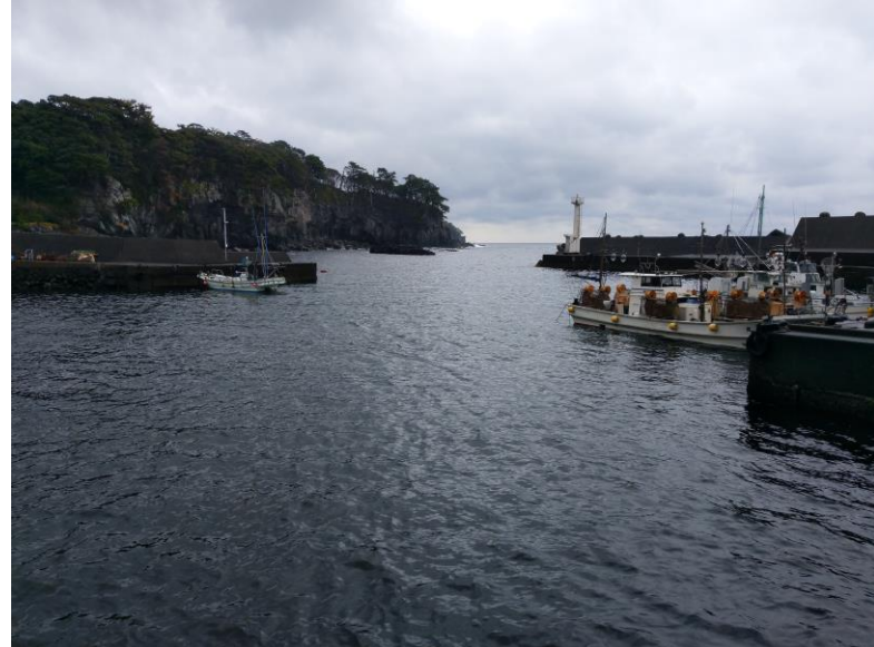
急峻な地形により、土砂流出は海の汚染に直結する
